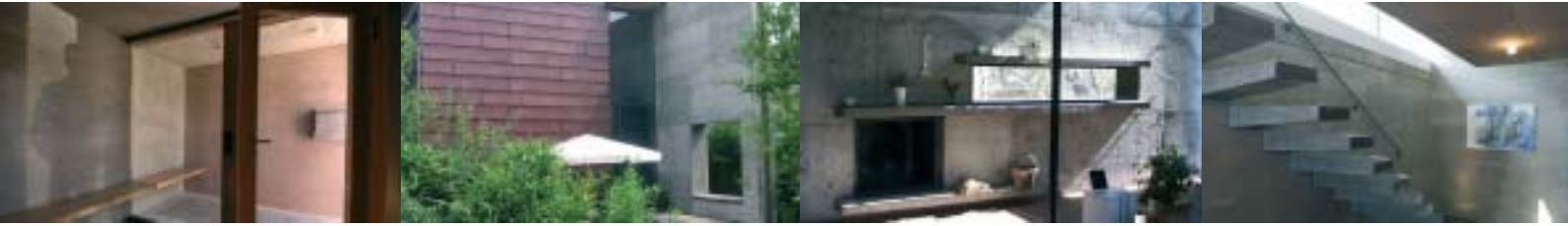
Rohe Sichtbetonoberflächen für drinnen und draußen. Roher Beton im Kontrast zu farbig lasierten zementgebundenen Spanplatten. Die roh belassene Betonwand mit integriertem Kamin dominiert den Wohnraum im Hause Haug. So schön kann grau sein – Treppe und Sichtbetonwand im Haus Nedele.
